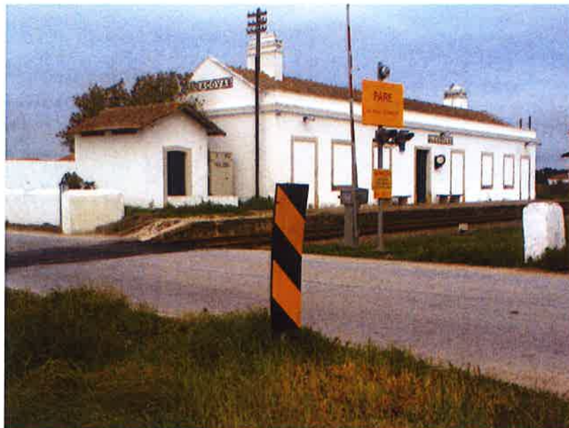
Fachada principal do apeadeiro
