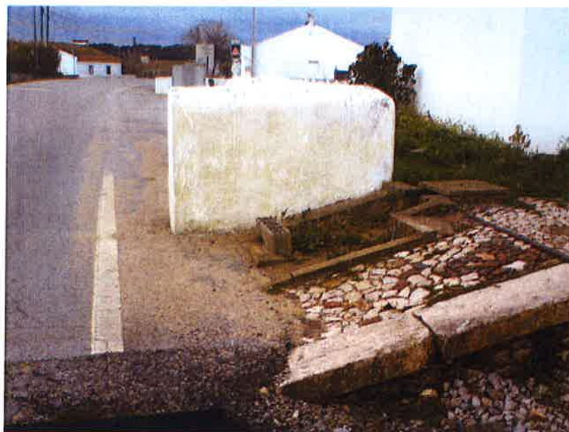
Acesso à plataforma pela Estrada Nacional N380
